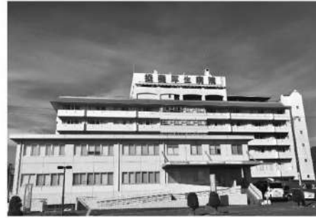
写真1 現在の揖斐厚生病院手前側が診療所開設予定の健診センター棟
