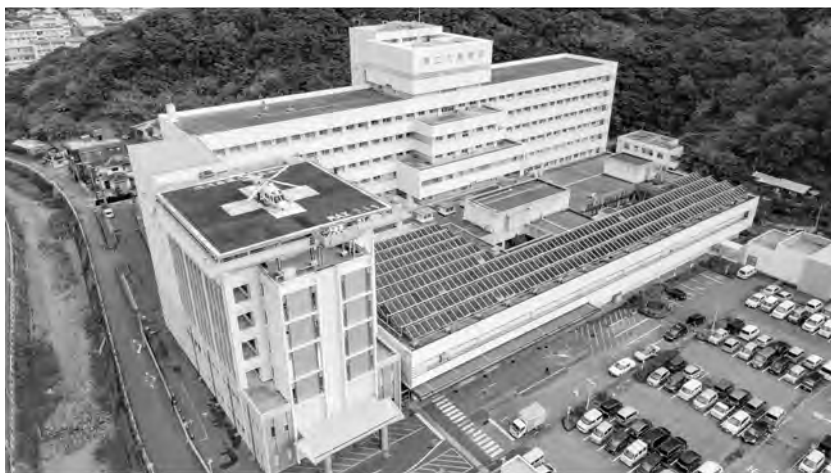
写真1 鹿児島県立大島病院全景
