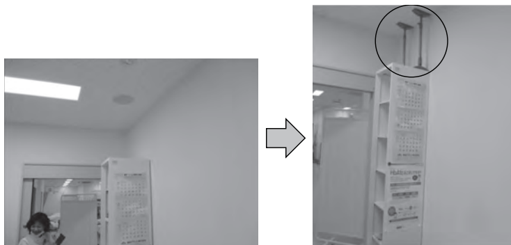
写真3 各室の棚に耐震対策で突っ張り棒を設置した。
