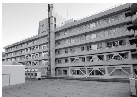
写真3 釜石病院 耐震工事後
