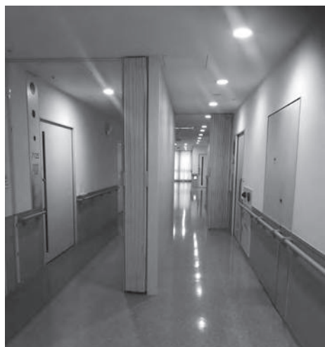
写真1 病棟廊下に設置された間仕切り板やアコーディオンカーテン
