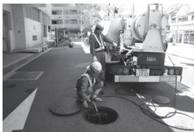
写真5 下水道のつまり処置
